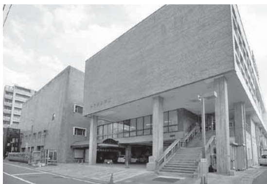
松戸市民会館プラネタリウム室 外観
